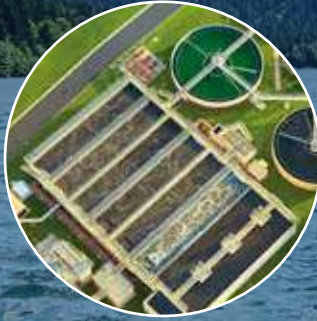
Atıksu Arıtma Sistemleri
